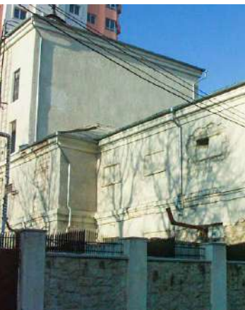
Здание бывшего пивзавода на пересечении Букурешть и Сфатул Țэрий
